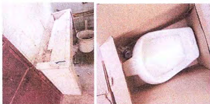
Foto 5: fundido de lavamanos y colocacion de mijitorios
