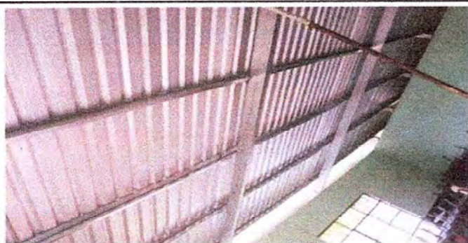
Foto 3: colocacion de techo en aula 1
