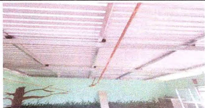
Foto 4: techo colocacion de techo en aula 2
