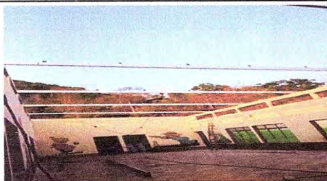
Foto1: colocacion de costaneras
